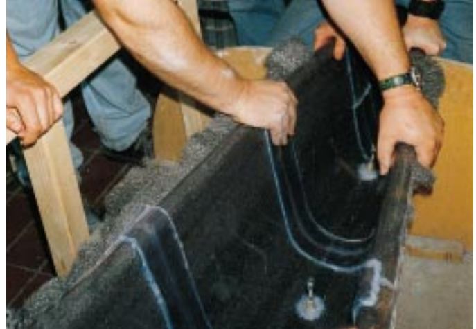
Bild 5: Edelstahlwollevlies zwischen Außen- und Innenschalung; Injektionsventile in der Innenschale montiert Foto: Lorenz
