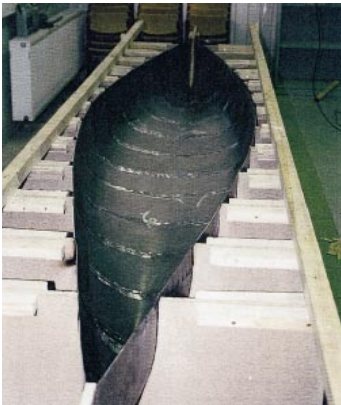
Bild 6: Außenschalung aus Stahlblech im Stützgerüst – Montage der doppelten Schalung (Kanu „Betunzel“) Foto: Buscher
