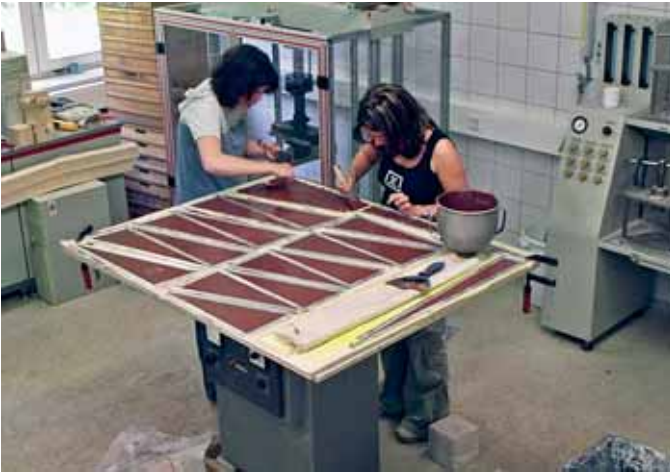
Kanubau unter Laborbedingungen: Dutzende von einzelnen Teilen wurden für die „Rosaik“ betoniert.
