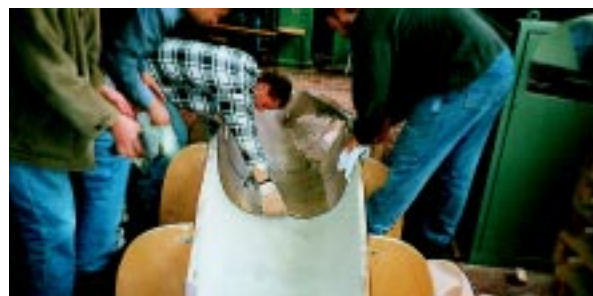
Bild 14: Einlegen und Anpassen der erwärmten PVC-Schalungselemente (Foto: Lorenz)
